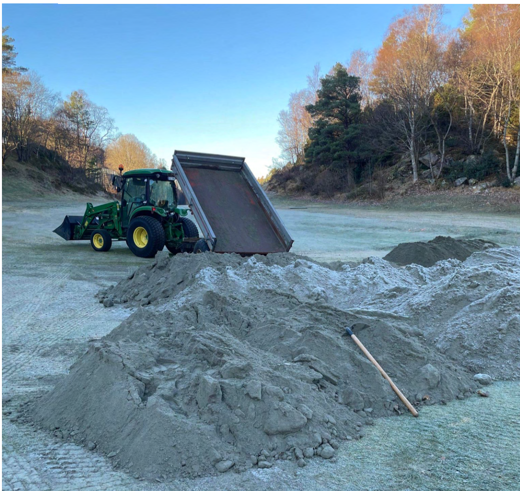
«Synken» på hull 7 fylles igjen med sand høsten 2023.
