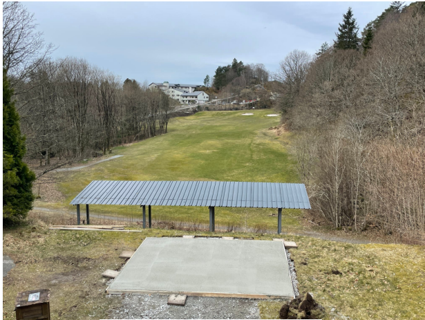
Støping av nytt teested på hull 4
