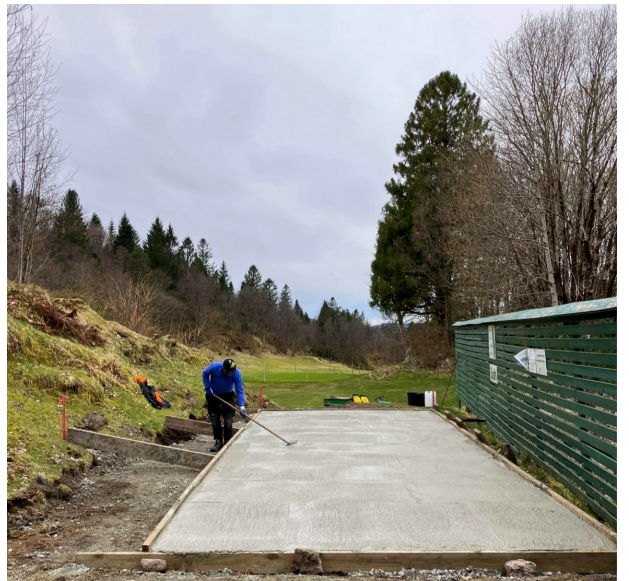
Støping av nytt teested på hull 3
