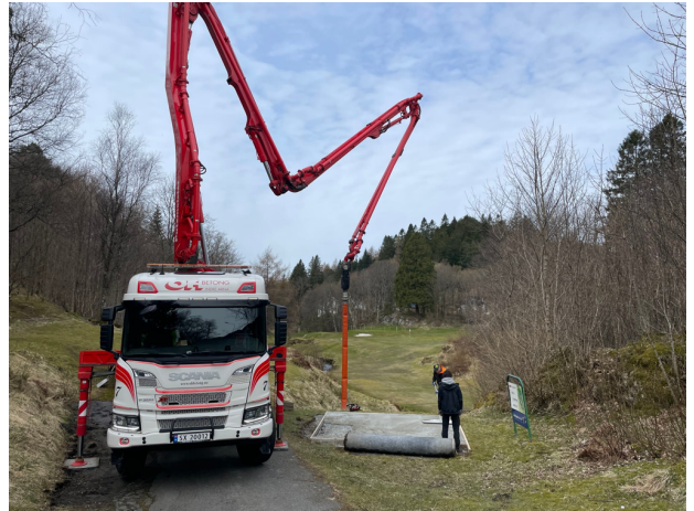
Støping av nytt teested på hull 11
